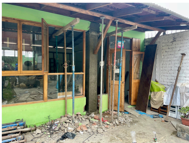
Neue Betonpfeiler müssen erdbebensicher verankert werden
